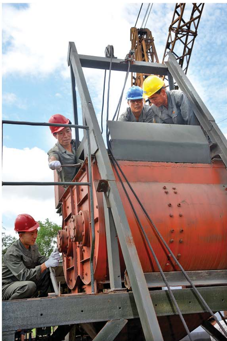
Сборка двухкорпусной бетономешалки.
