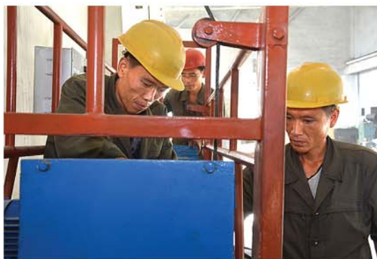
Сборка моторных самоподъемных лесов.
